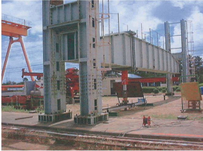
■鉛直載荷試験状況
