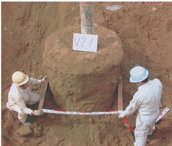
■ STマイクロパイル タイプI (GTM改良体出来形)
