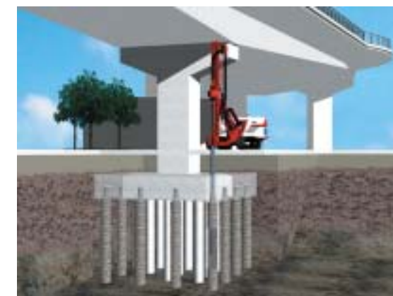
既設橋梁基礎の耐震補強
