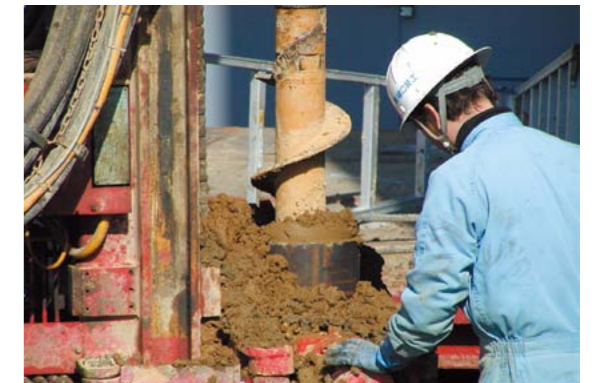
削孔・排土状況
