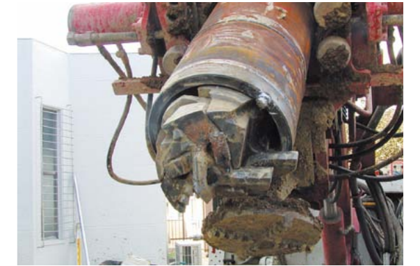
削孔ツール装備状況
