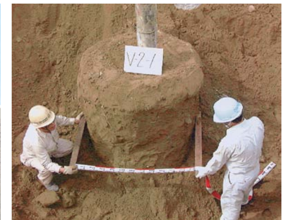
改良体造成状況
