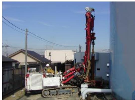
図-2.3.17 耐震補強施工状況
