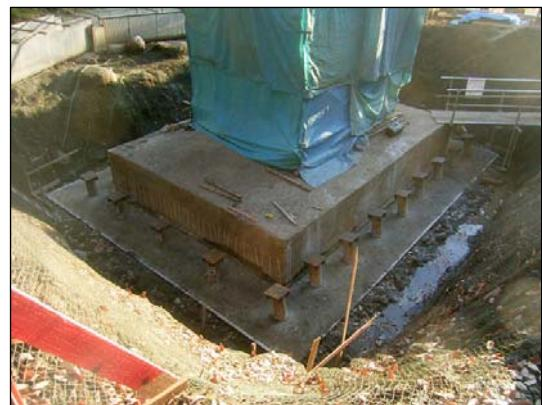
図-2.3.29 増し杭補強状況
