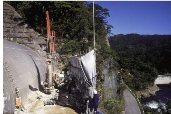
図-2.3.9 L型擁壁基礎杭施工状況
