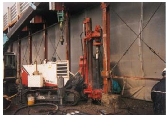
図-2.3.11 スノーケッド基礎補強状況
