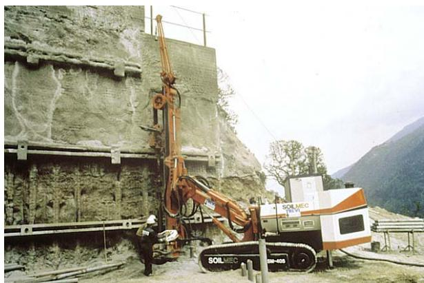
図-1.1.1 海外でのマイクロパイル施工事例
