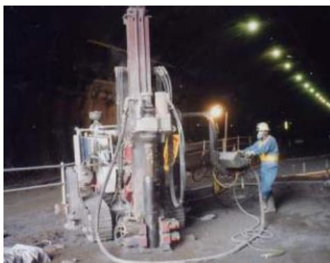
図-2.3.24 脚部補強工施工状況
