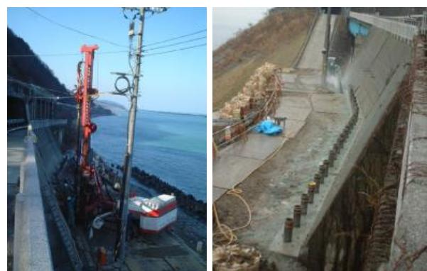
図-2.3.13 既設擁壁の補強状況
