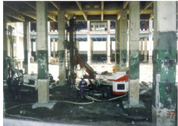
図-1.1.2 海外でのマイクロパイル施工事例
