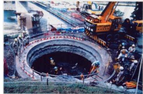
図-2.4.12 貯留水槽掘削状況
