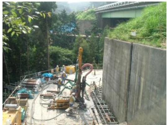
図-2.3.21 組杭抑止杭施工状況
