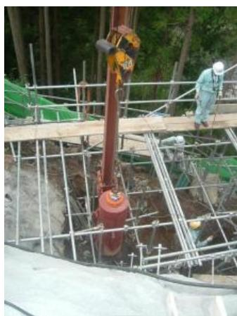
図-2.3.34 急速載荷試験状況<sup>9)</sup>
