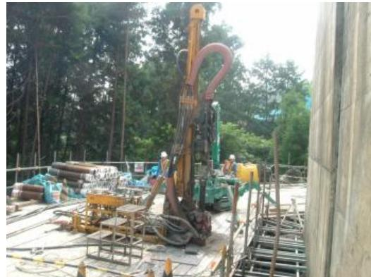
図-2.6.4 削孔機械スキッドタイプ
