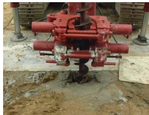
図-2.4.4 オーガー単管削孔状況
