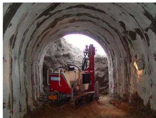
図-2.3.25 側壁導坑状況
