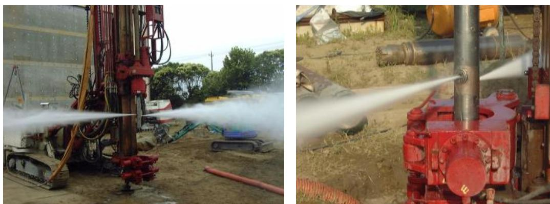
図-2.4.6 二重管ツインノズルによる超高压噴射
