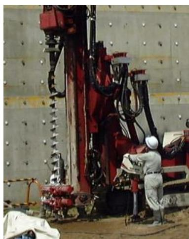
図-2.4.8 オーガー削孔状況
