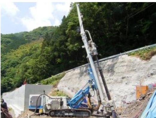
図-2.6.1 削孔機械 SM401
