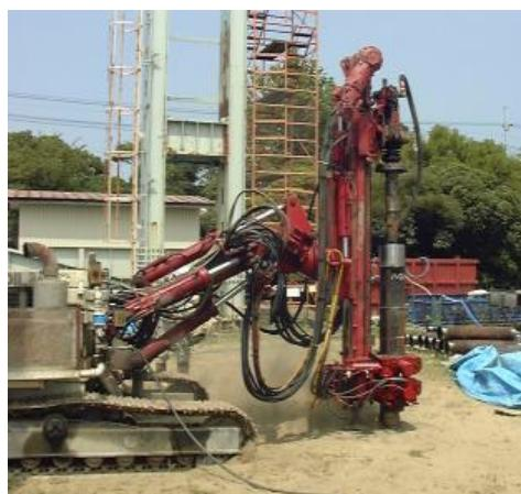
図-2.3.3 二重管削孔・钢管打設状況
