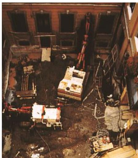
図-1.1.3 海外でのマイクロパイル施工事例
