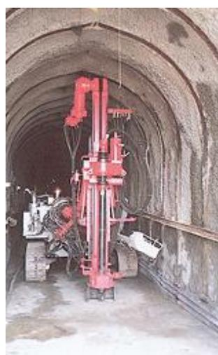
図-1.1.4 国内でのマイクロパイル施工事例
