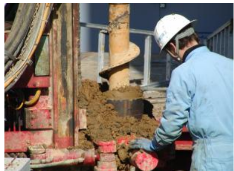
写真-1.3.8 回転式削孔状況 (オガ-併用切削拡径ビット)
