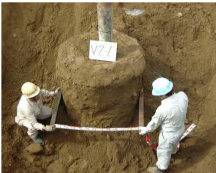
写真-2.3.7 改良体造成状况(砂质土)
