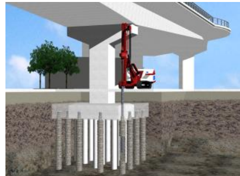
写真-2.3.8 既設構造物基礎の補強
