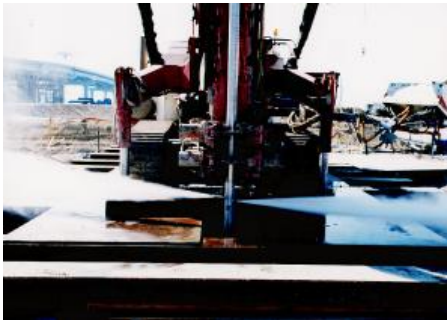
写真-2.3.5 清水高压喷射状况
