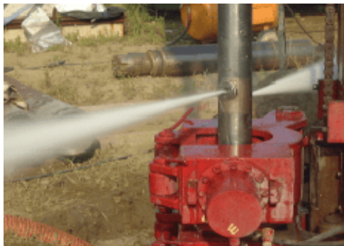
写真-2.3.1 高圧噴射状況 SM400 改良体造成機械
