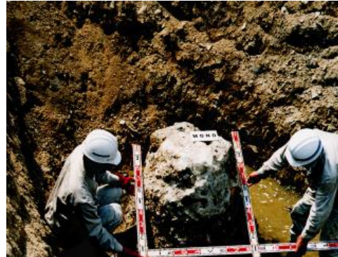
写真-2.3.6 改良体造成状况(シルty土)
