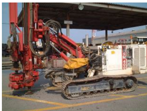
写真-1.3.4 削孔機械 SM400
