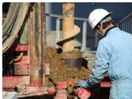
写真-1.3.8 回転式削孔状況 (オガー併用切削拡径ビット)
