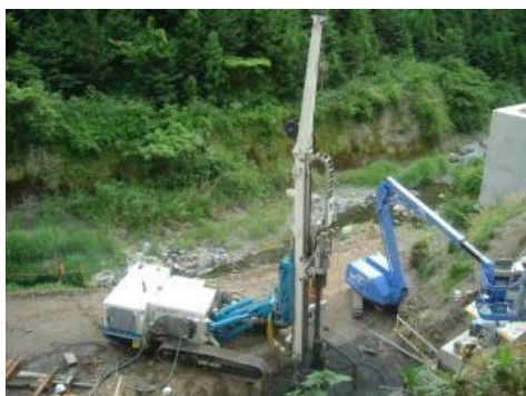
写真-1.3.3 削孔機械 SM401
