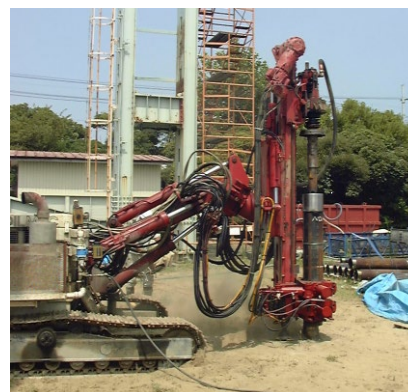
写真-1.3.2 D.T.H による削孔状況
