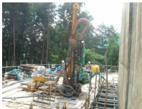
写真-1.3.6 削孔機械 スキッドタイプ
