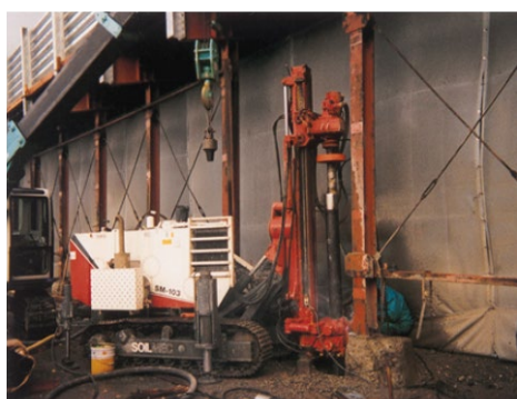
写真-1.3.5 削孔機械 SM103
