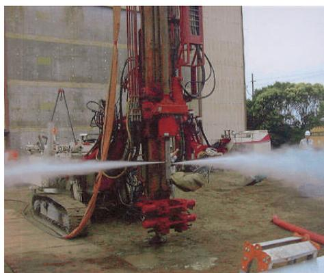
図-1.1.1 G T M工法 高压噴射状況
