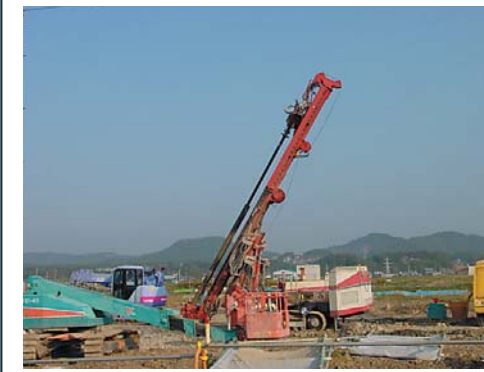
斜杭30度の施工状況
