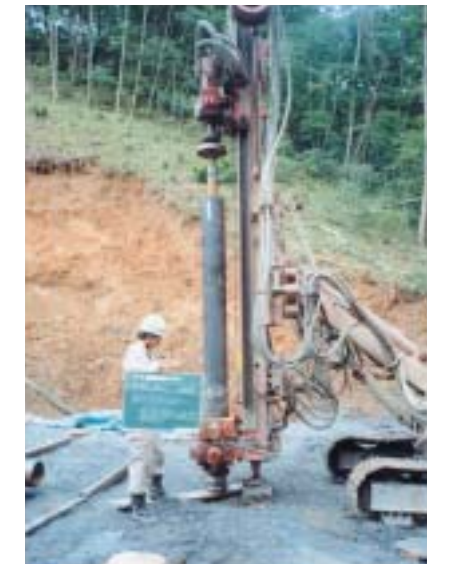
抑止杭の施工状況
