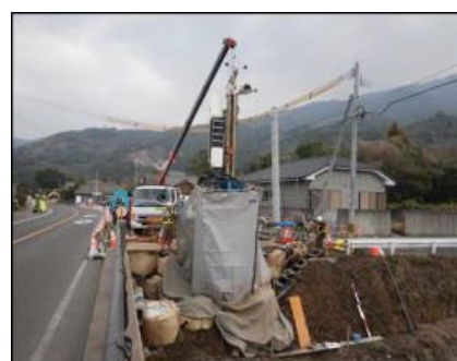
削孔状況(A2)
