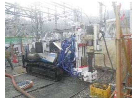
施工状況(超低空頭仕様)
