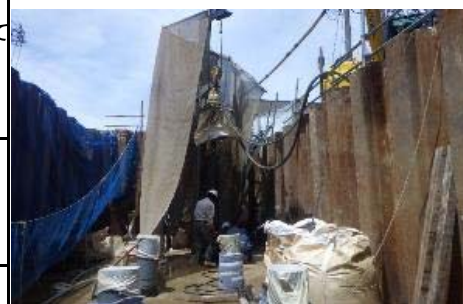
削孔状況(締切内)
