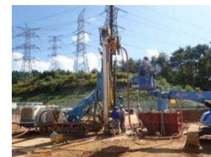
鋼管接続状況
