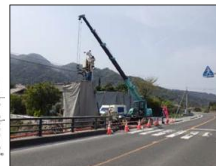
削孔状況(A1)
