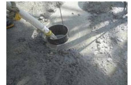
注入(鋼管外周リーク確認)
