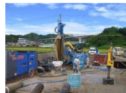
打設状況全景
