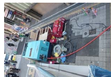
プラントヤード(歩道)
