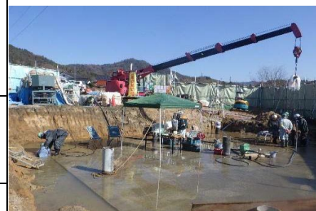
グラウト注入状況
