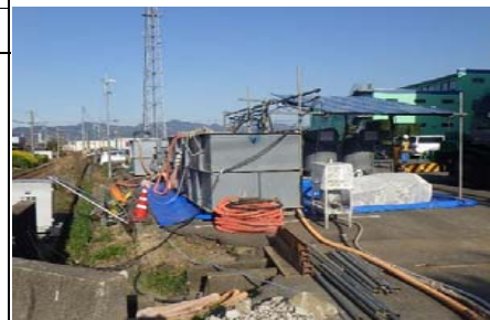
プラント設置
