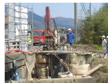
施工状況(削孔)
