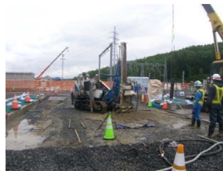
写真-1 施工全景
