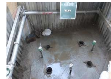
削孔完了全景
