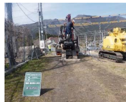
ボーリングマシン搬入状況
