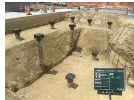
写真-2 完成写真
