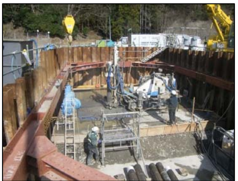
写真-1 施工全景
