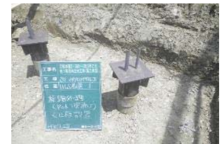
杭頭部処理(支圧板設置)
