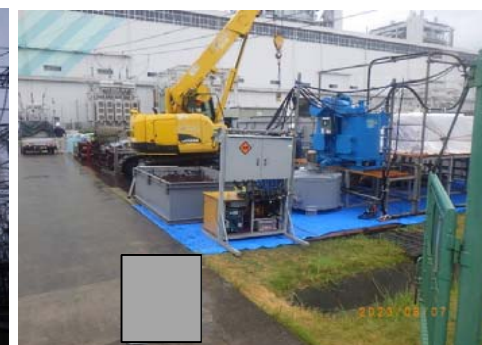
プラント設置状況
