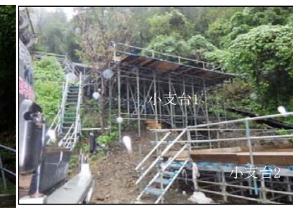
単管足場設置状況
