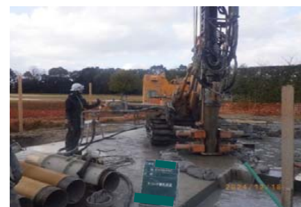
ケーシング削孔状況
