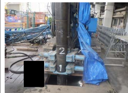
施工全景(A2)
