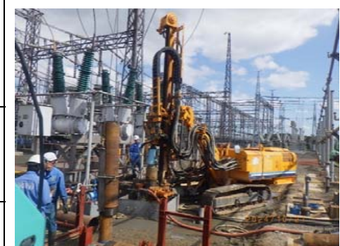
ケーシング削孔状況
