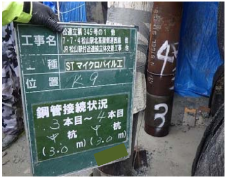
鋼管接続状況
