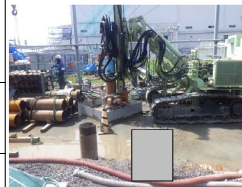
ケーシング削孔状況
