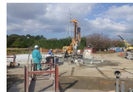
施工状況全景
