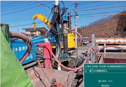
施工状況(削孔・建込)
