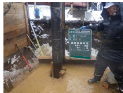
鋼管接続状況
