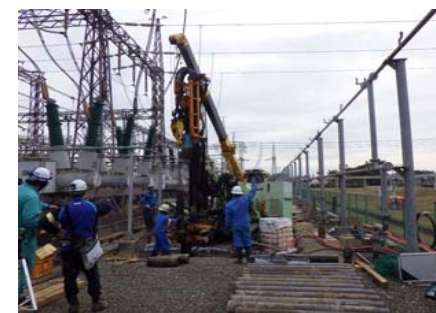
施工状況全景
