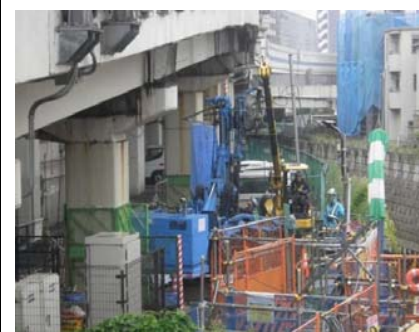
施工全景(A1)
