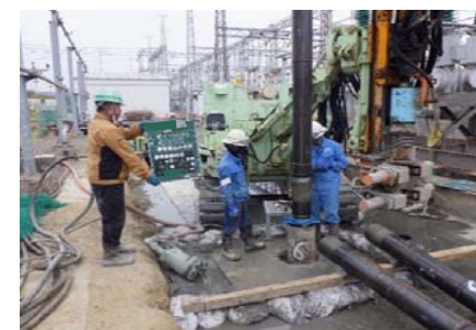
鋼管接続状況
