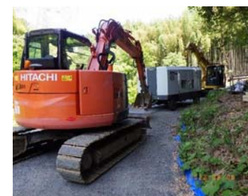
機材搬入出状況
