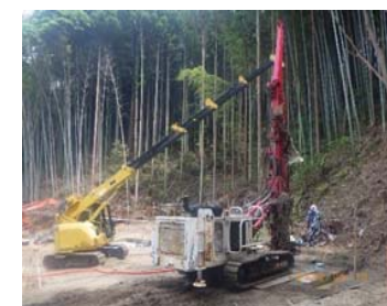
削孔鋼管打設状況
