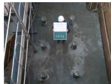
施工完了全景(支圧板取付前)
