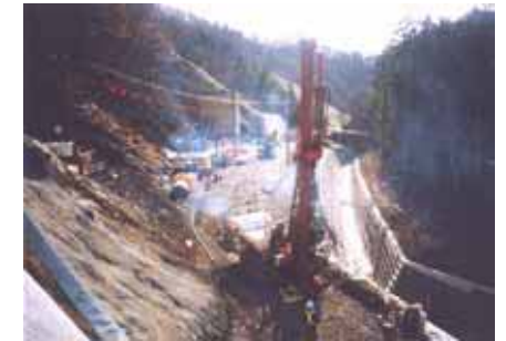
マイクロパイル施工状況
