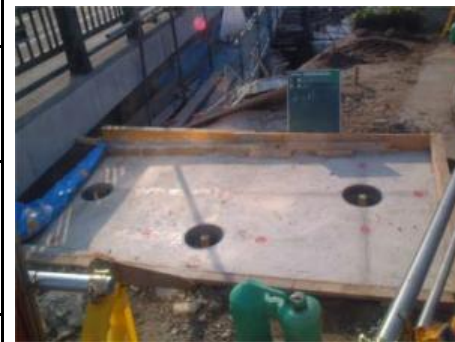
A1橋台 着手前全景
