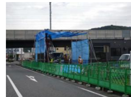
施工状況(全景)P2側
