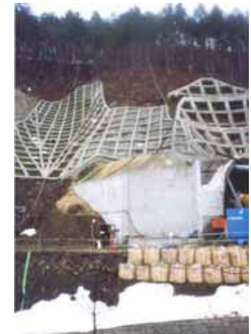
擁壁施工状況
