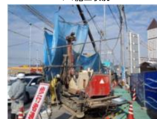
A1施工状況
