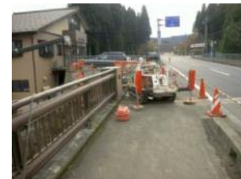
機械据付状況
