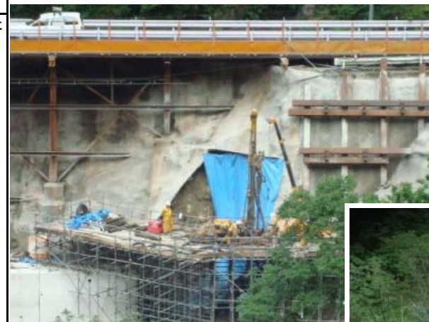
施工状況(全景)
