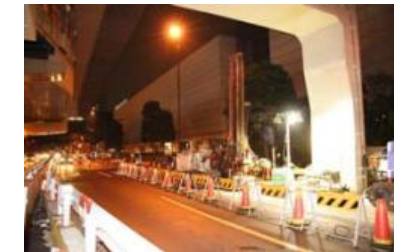
施工状況写真(全景)
