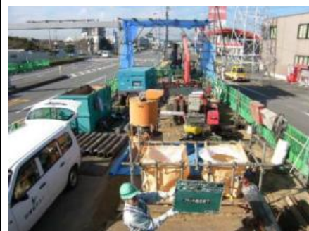
施工状況(全景)P2側
