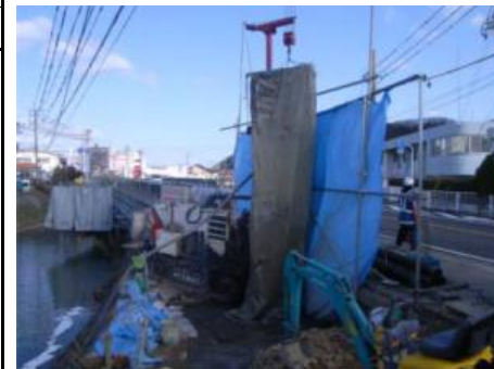
A3橋台 施工状況(飛散防止対策)
