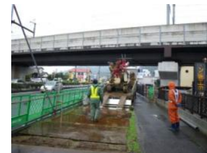
機械搬入状況(全景)P1側
