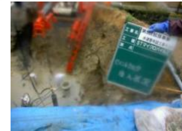
グラウト注入状況
