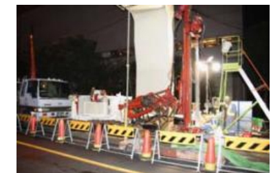
改良体造成状況
