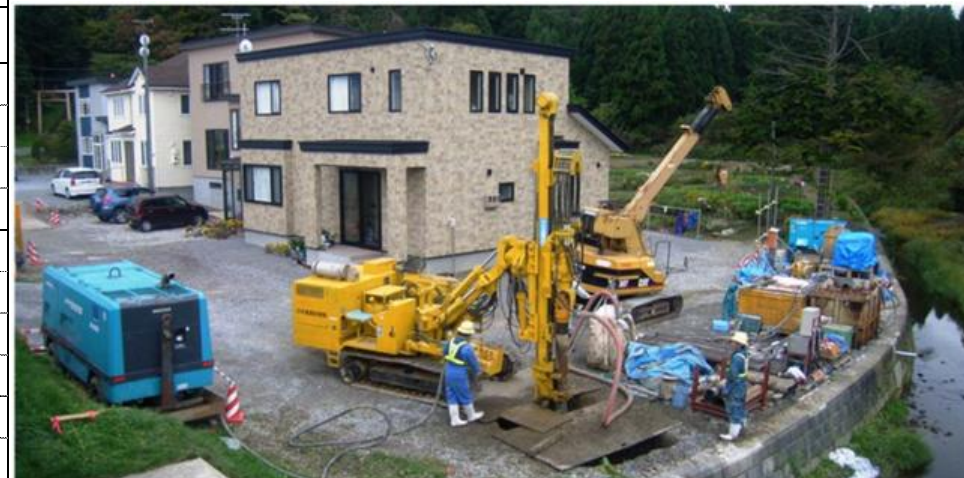
施工状況全景
