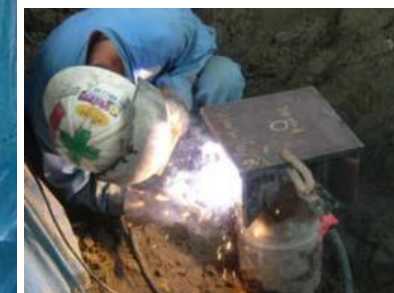
頭部処理状況
