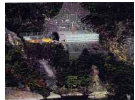
工事区域全景
