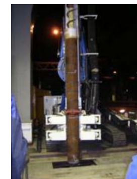
鋼管建込状況
