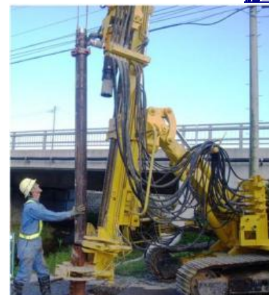
鋼管杭建込状況
