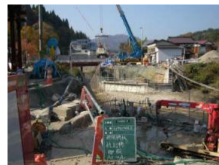
機械搬入状況(クレーン使用)
