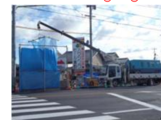
P3施工状況
