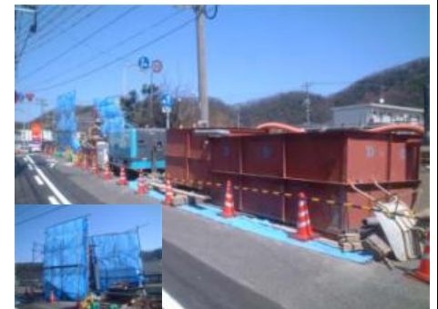
A1橋台 プラントおよび飛散防止フェンス
