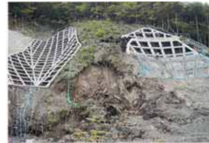
トンネル坑口部状況
