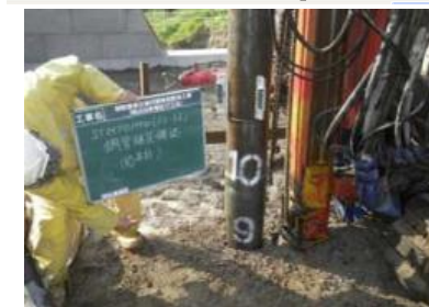
鋼管継足確認
