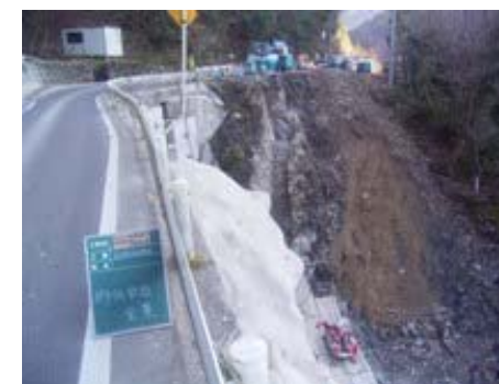
(グラウト仮設全景)
