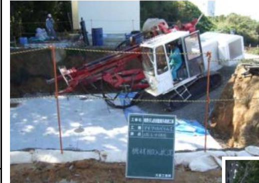
機械進入状況
