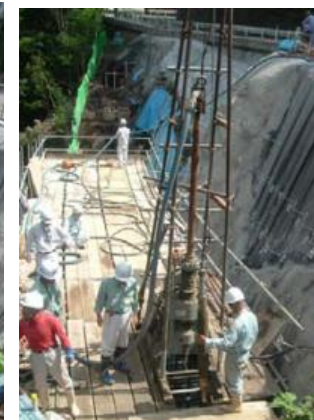
注入加圧状況 施工状況写真
