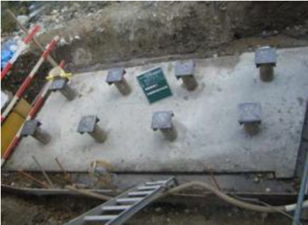
A2 完成時全景
