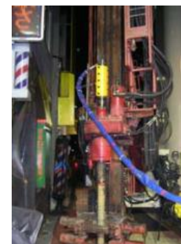
改良体造成状況
