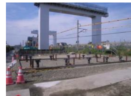
杭頭処理完了
