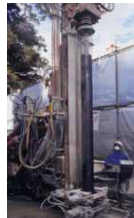
マイクロパイル打設状況
