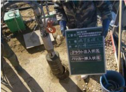
A1 ハンマー挿入状況
