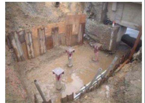
A1橋台 完成時全景
