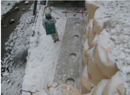
A2 着工前全景
