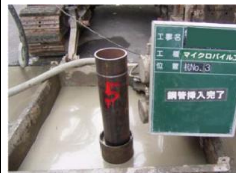
鋼管挿入完了
