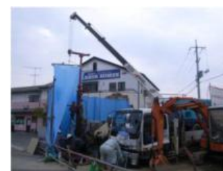
P4施工状況
