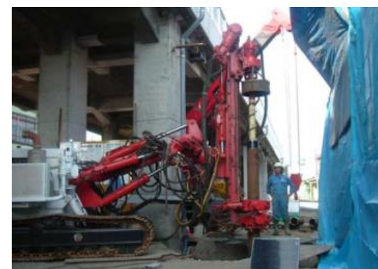
施工状況全景
