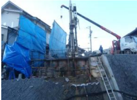
A2 施工状況(飛散防止対策)
