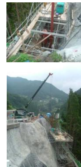
急速載荷試験状況
