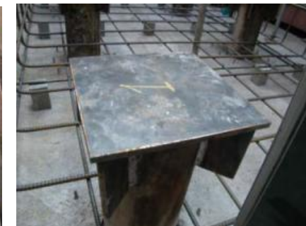
施工完了全景(支圧板取付後)
