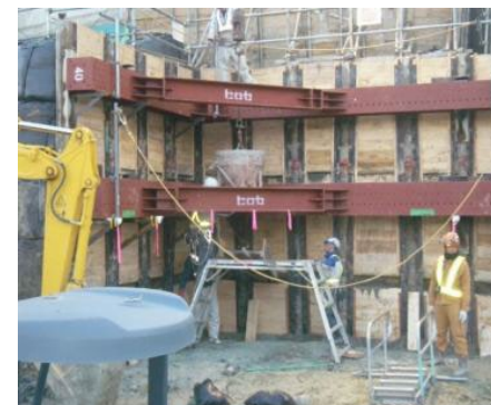
仮設土留め施工完了
