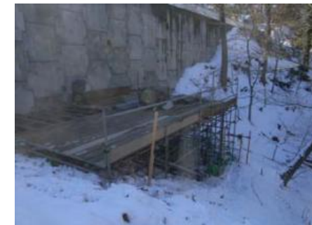
足場組立状況
