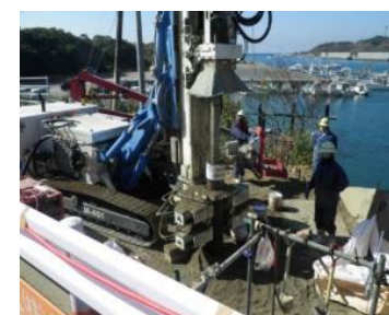
施工状況③
