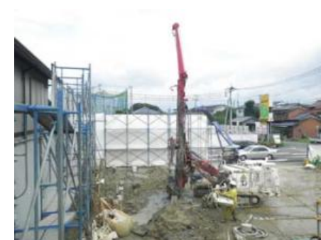
削孔・鋼管打設状況
