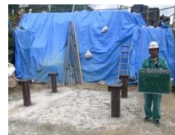
右岸側施工完了
