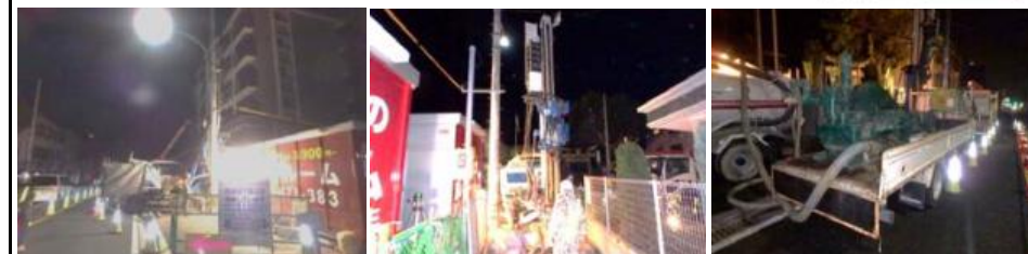
削孔状況(P1側)
