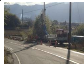
施工状況①
