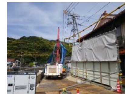
防音シート設置状況
