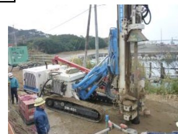
施工状況①
