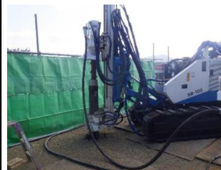
削孔状況 (φ216.3mm SMB-G)
