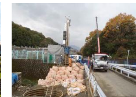
削孔状況(A1)
