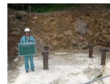
左岸側施工完了
