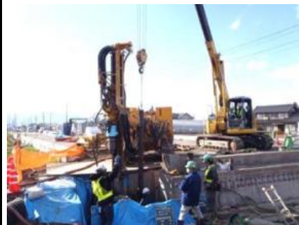
鋼管建込状況
