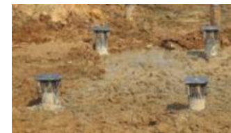
打設完了状況
