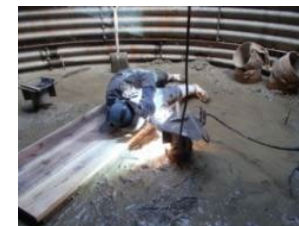
頭部処理状況
