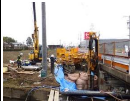
施工状況(1期線A1橋台)
