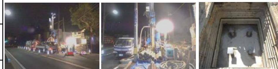
削孔状況(P2・P3側)
