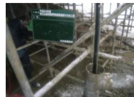
グラウド注入状況(養生)
