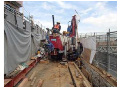
削孔機据付状況
