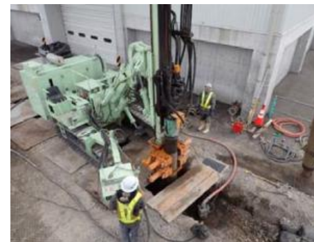
二重管削孔 ( \phi 315.8\text{mm} )
