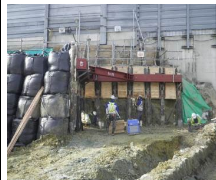
横矢板設置状況
