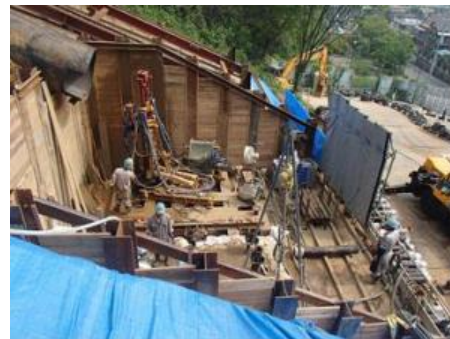
施工中全景(打設)
