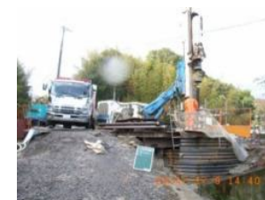
施工状況②
