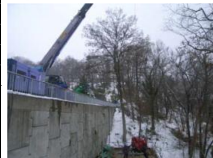
機材搬入状況
