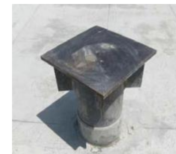
機械式継手 頭部処理完成
