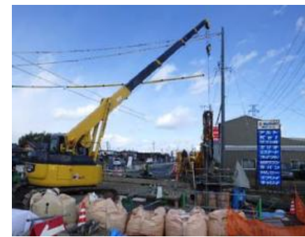
施工状況(2期線A1橋台)
