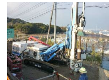
施工状況②
