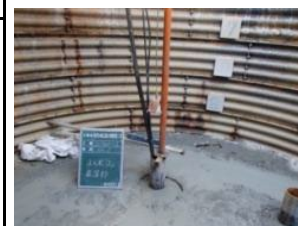
杭頭部変位防止処理状況
