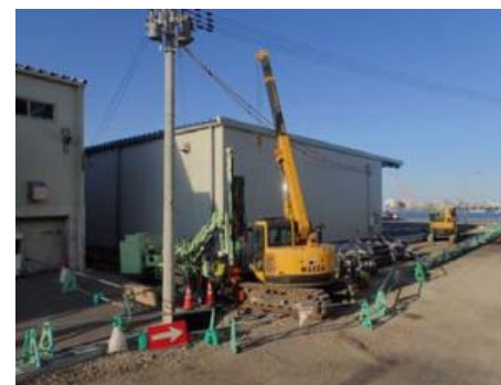
施工状況全景
