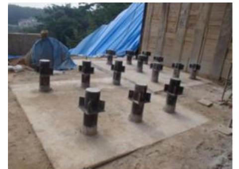
施工完了全景
