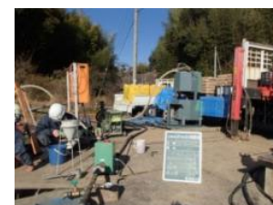
注入プラント状況
