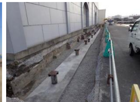
頭部処理状況
