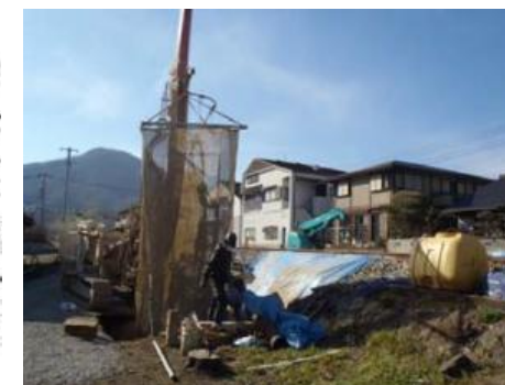
飛散防止ネット設置状況
