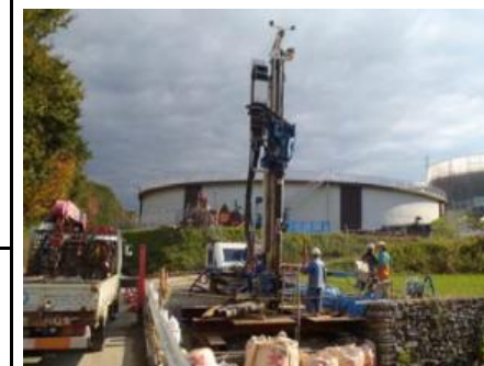
削孔状況(A2)
