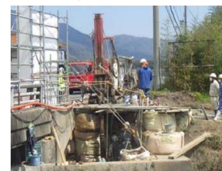
施工状況(削孔)
