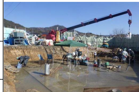
グラウト注入状況
