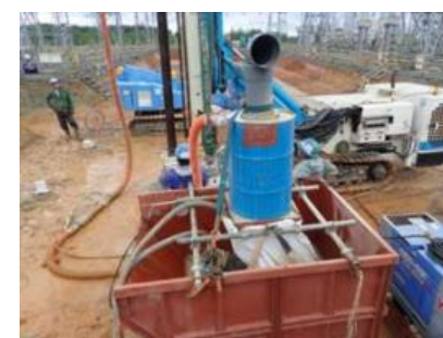
削孔排土処理状況
