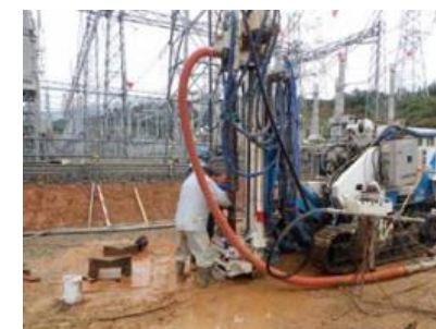
鋼管接続状況
