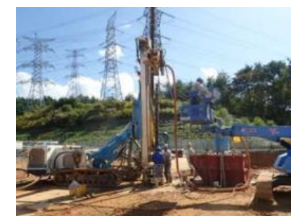
鋼管接続状況
