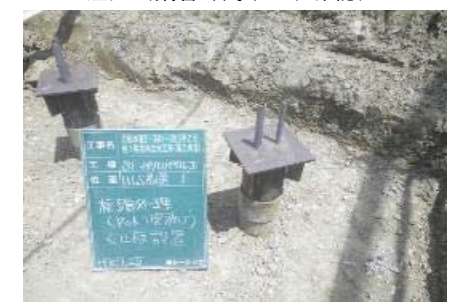
杭頭部処理(支圧板設置)
