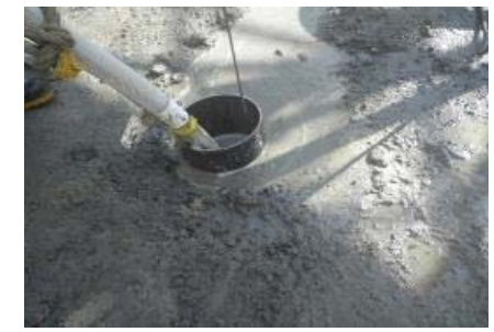
注入(鋼管外周リーク確認)
