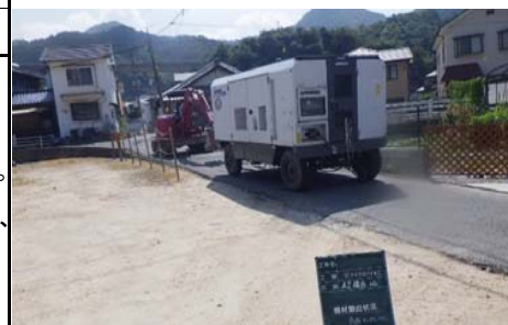
機材搬入状況
