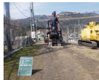
ボーリングマシン搬入状況
