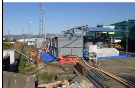
プラント設置
