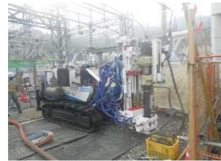
施工状況(超低空頭仕様)
