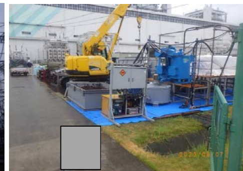
プラント設置状況
