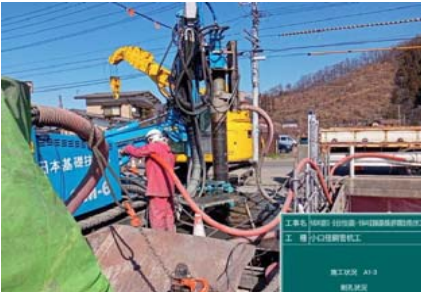
施工状況(削孔・建込)
