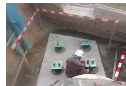
杭頭グラウト充填状況
