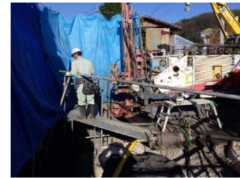
施工風景②
