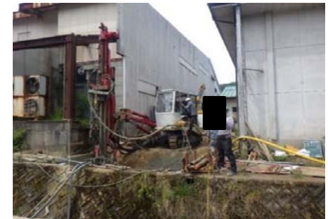
機械据付状況
