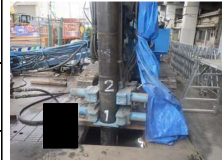
施工全景(A2)
