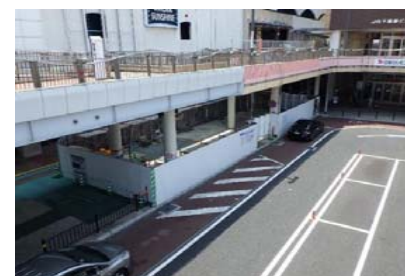
施工ヤード全景
