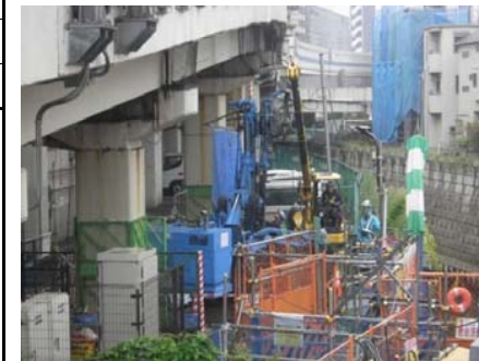
施工全景(A1)
