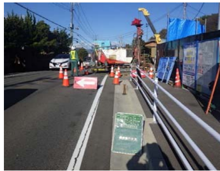
施工風景①
