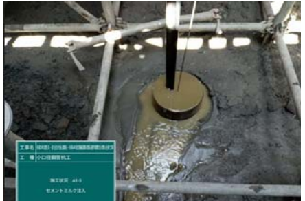
施工状況(注入)
