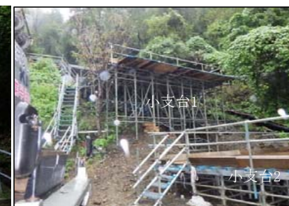
単管足場設置状況
