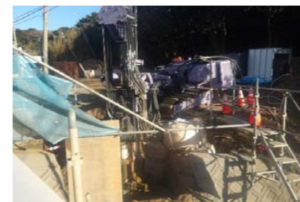
機械設置状況
