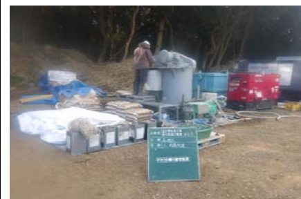
プラント設置状況
