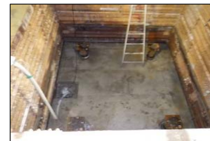
削孔完了全景
