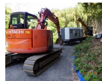
機材搬入出状況
