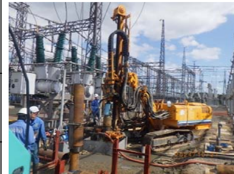
ケーシング削孔状況
