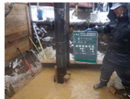
鋼管接続状況
