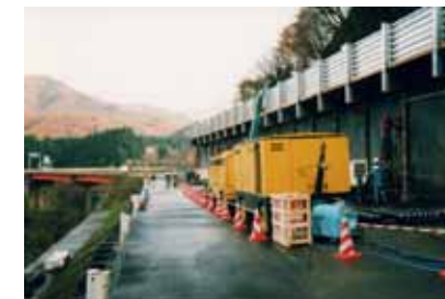
工事区域全景（測道の通行確保）
