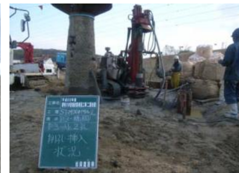
SM-103(空頭制限)施工状況
