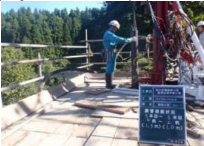
施工状況(盛土部)
