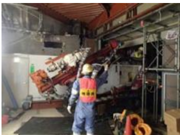
建屋内への進入
