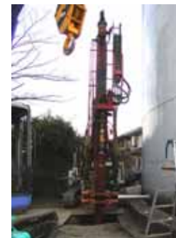
狭隘空間での低振動・低騒音施工
