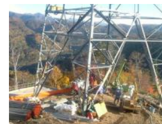
施工状況全景
