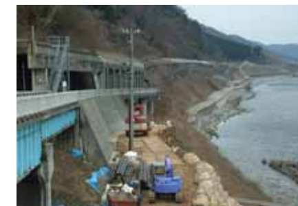
施工区域全景
