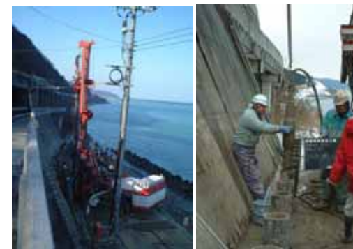
マイクロパイル施工状況
