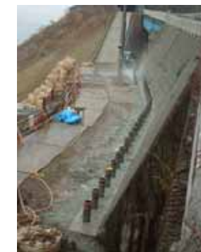
打設完了全景
