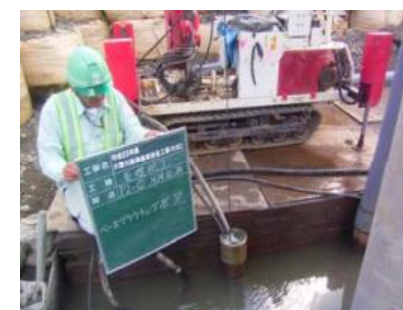
(グラウト注入状況)
