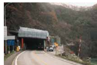
工事区域全景
