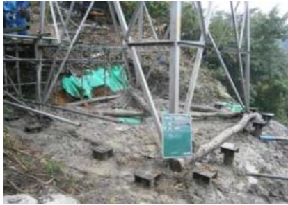
施工完了(鉄塔部)
