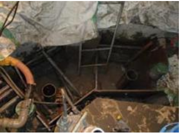
鋼管打設完了
