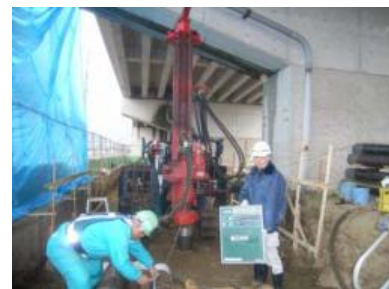
削孔状況(空頭あり)
