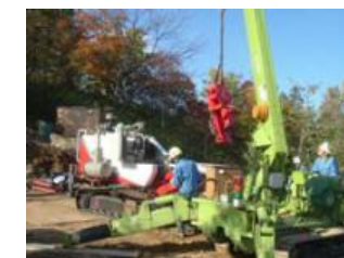
削孔機械組み立て状況
