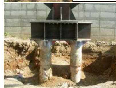
打設完了状況
