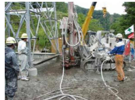
鉄塔外部での施工
