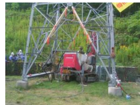
鉄塔内部での施工
