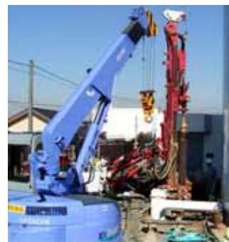
狭隘空間での低振動・低騒音施工
