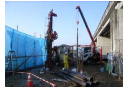
削孔状況(空頭なし)
