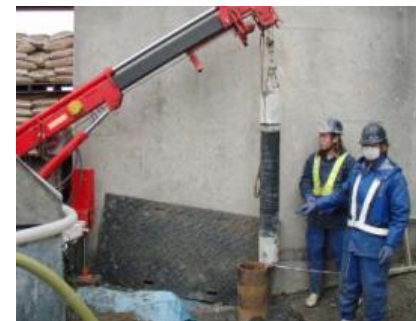
バッカー挿入状況
