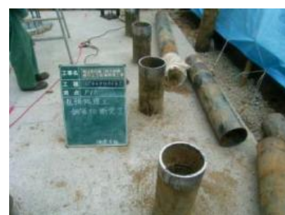
鋼管天端切り揃え状況
