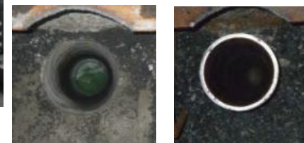
コアボーリング完了 マイクロパイル削孔完了
