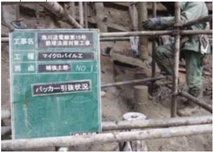
施工状況(グ ラウト注入完了、パ ッカー引抜状況)
