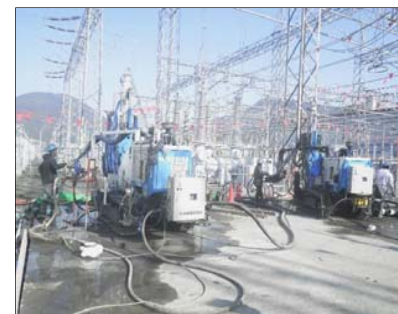
施工状況 (2セット施工)
