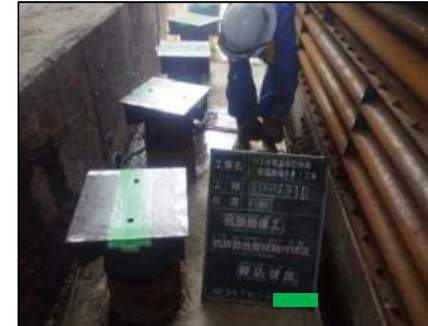
杭頭処理(取付状況)
