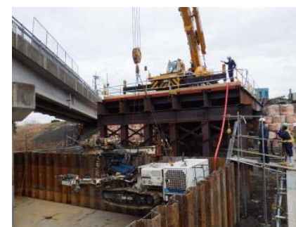
ボーリングマシン吊り込み状況
