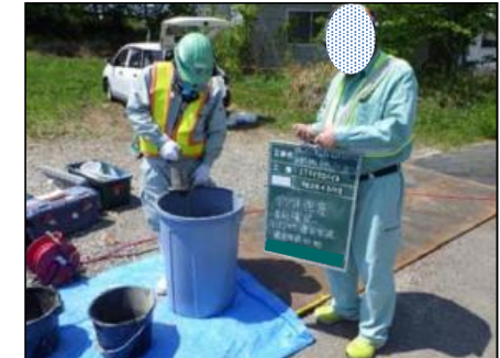
グラウト試験練り
