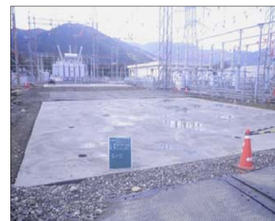
着手前(均しコン設置)
