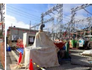
排土処理 (排出側)
