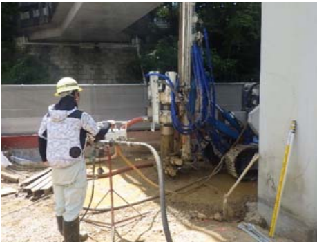
施工状況(削孔・建)
