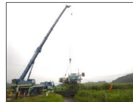
ボーリングマシン搬入(吊込み)状況
