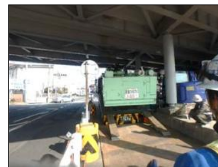
ボーリングマシン搬入
