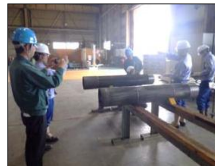
鋼管工場検査
