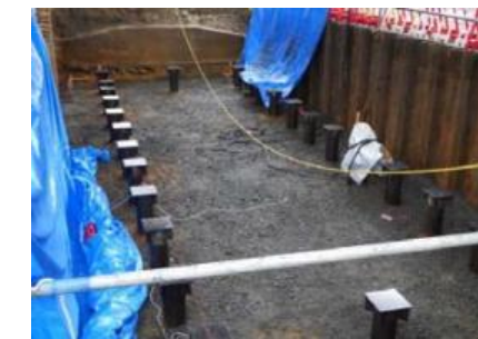
施工完了全景
