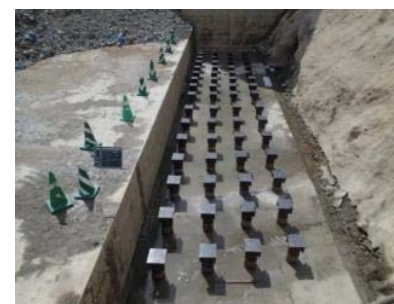
施工完了全景
