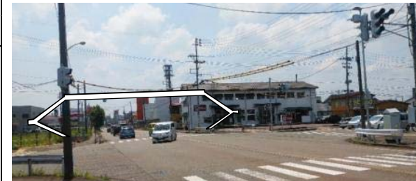
施工箇所全景
