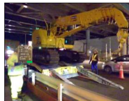
クローラクレーン夜間搬入
