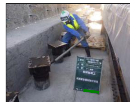
杭頭処理(取付状況)
