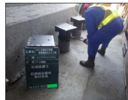
杭頭処理(取付状況)
