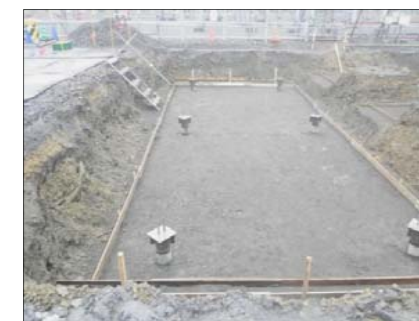
杭頭部処理完了(支圧板設置)
