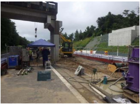
施工状況(注入)
