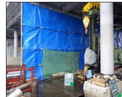
飛散防止シートフェンス
