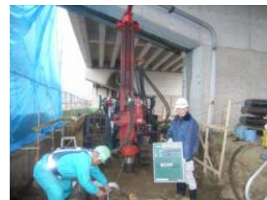
削孔状況(空頭あり)
