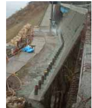
打設完了全景
