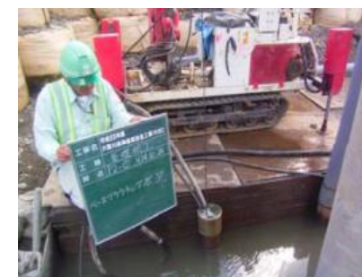
(グラウト注入状況)
