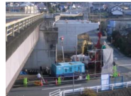
施工状況(増設側)
