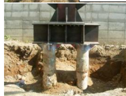
打設完了状況
