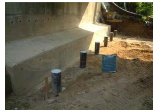
施工完了全景(支圧板取付前)
