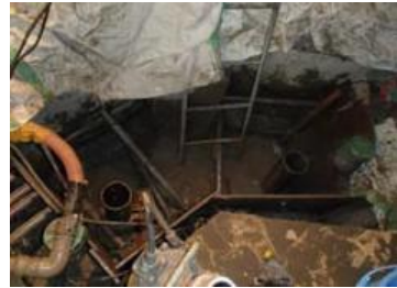
鋼管打設完了
