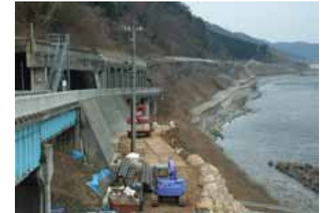
施工区域全景
