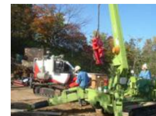
削孔機械組み立て状況
