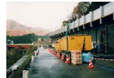
工事区域全景(測道の通行確保)
