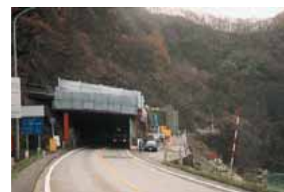
工事区域全景
