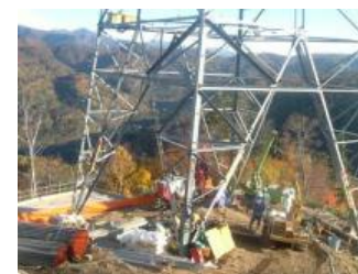
施工状況全景
