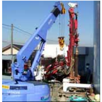
狭隘空間での低振動・低騒音施工
