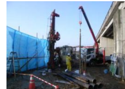
削孔状況(空頭なし)
