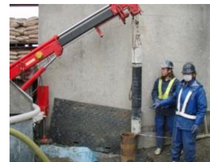
バッカー挿入状況
