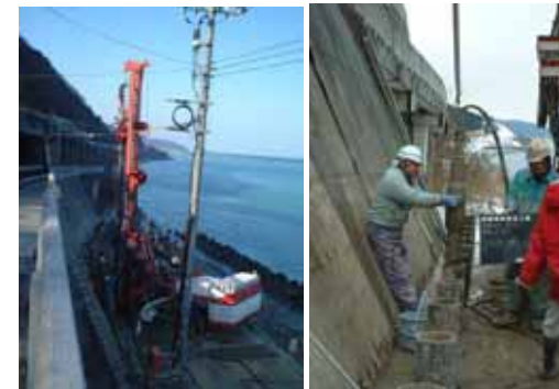
マイクロパイル施工状況
