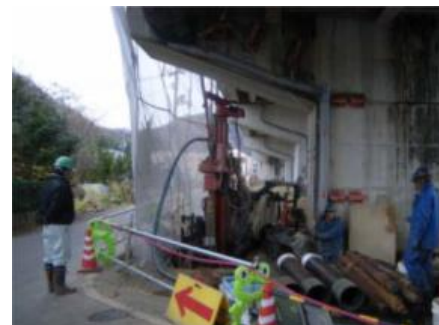
施工状況(既設側)
