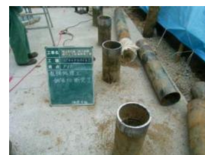
鋼管天端切り揃え状況
