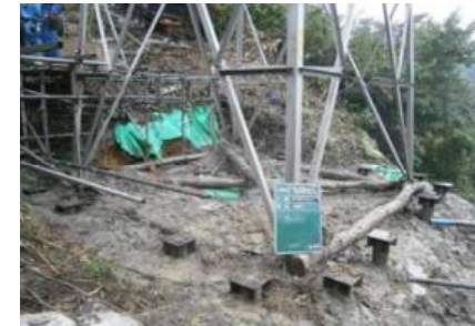
施工完了(鉄塔部)
