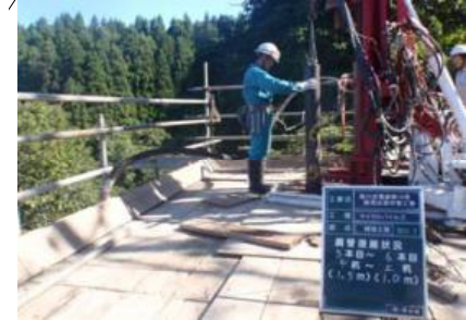
施工状況(盛土部)
