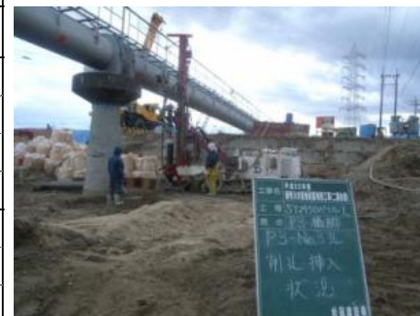
SM-400施工状況
