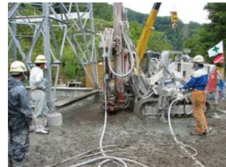
鉄塔外部での施工
