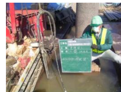
(グラウト注入状況)
