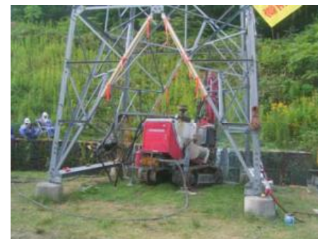
鉄塔内部での施工
