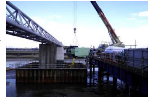
ボーリングマシン吊降ろし状況
