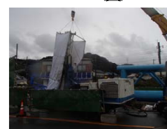
飛散防止吊り養生
