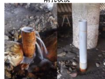
水頭差による湧水および対策
