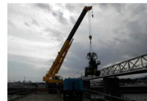
ボーリングマシン吊降ろし状況
