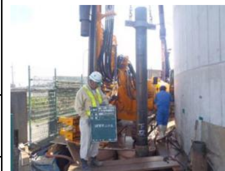
鋼管建込状況
