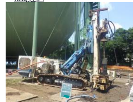
ボーリングマシン据付状況
