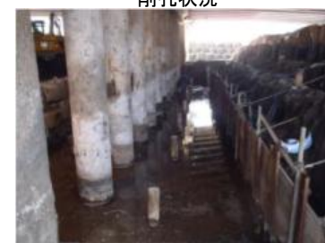
支圧板取付前全景
