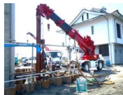
削孔状況(建柱式)
