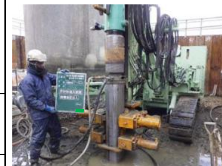
グラウト注入状況
