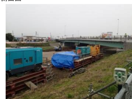
施工箇所 全景
