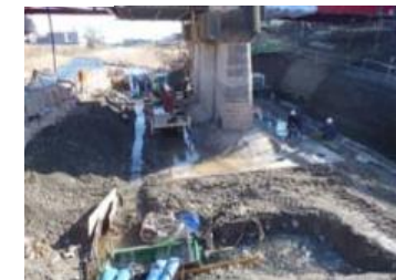
施工状況全景
