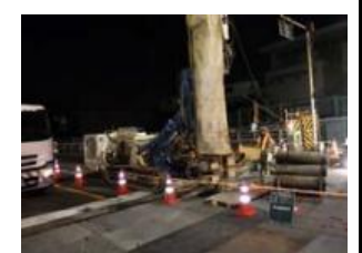
飛散養生状況
