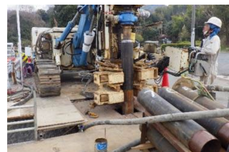
ケーシング削孔状況
