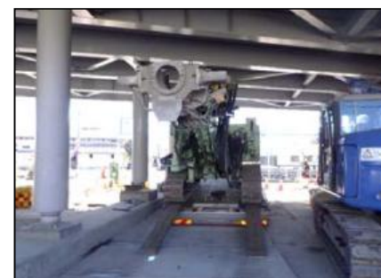
ボーリングマシン搬入
