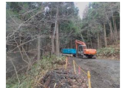
機材運搬状況
