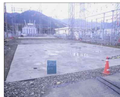
着手前(均しコン設置)
