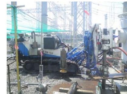
施工状況 (超低空頭仕様)
