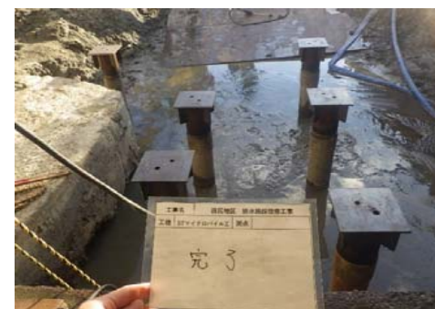
施工完了(杭頭管仕様)
