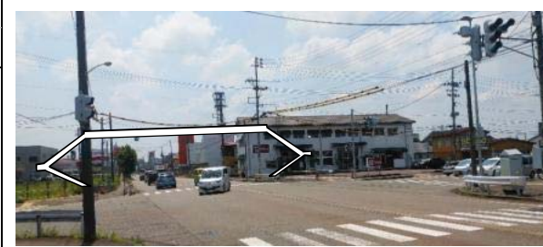
施工箇所全景
