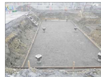
杭頭部処理完了(支圧板設置)
