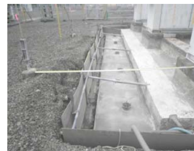
着手前 (均しコン箱抜き)
