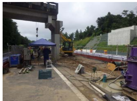
施工状況(注入)
