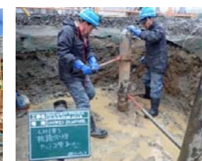
ヤットコ管取り外し
