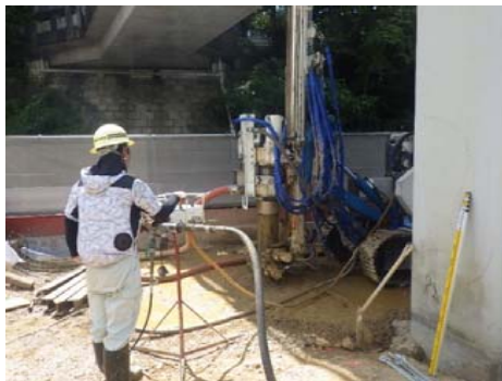
施工状況(削孔・建)
