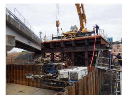
ボーリングマシン吊り込み状況
