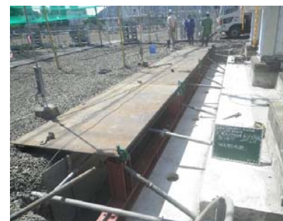
削孔用仮設構台設置
