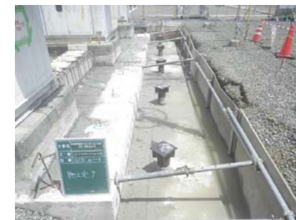
杭頭部処理 (支圧板設置)
