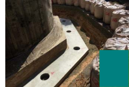
着手前(均しコンクリート打設完了)
