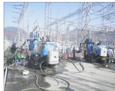
施工状況 (2セット施工)
