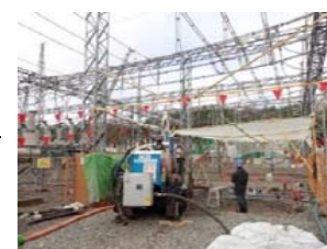
機械移動設置
