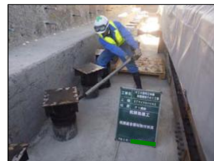
杭頭処理(取付状況)
