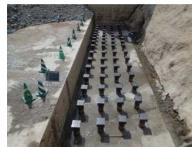
施工完了全景
