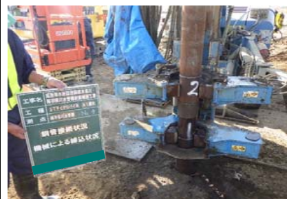
鋼管接続状況
