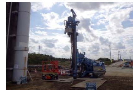
機械据付状況
