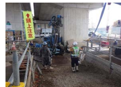
施工機械設置状況
