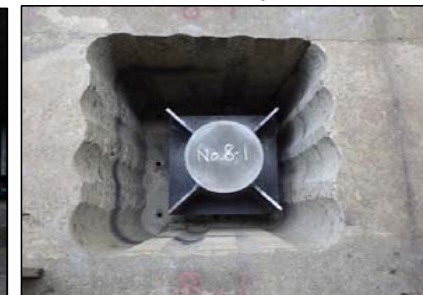
削孔完了
