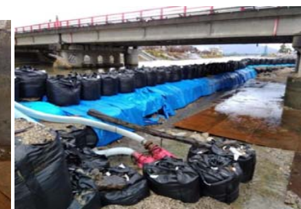
施工前(河川切り替え状況)
