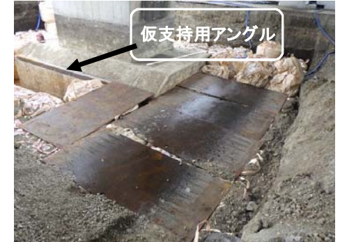
重機足場設置
