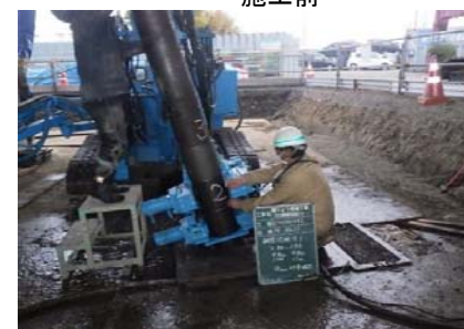
削孔状況(斜杭)
