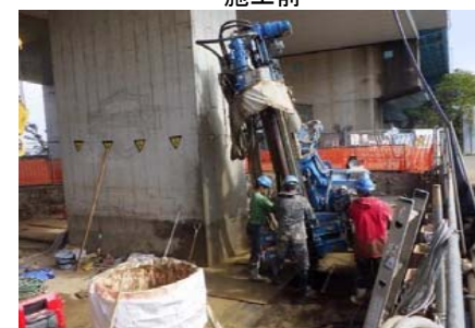
削孔状況(斜杭)
