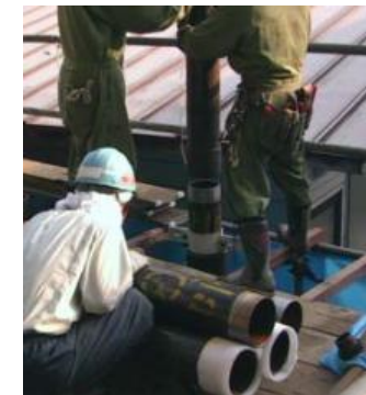
二重鋼管建込み状況
