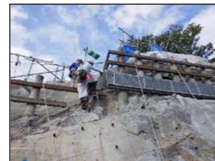
杭頭結合施工状況
