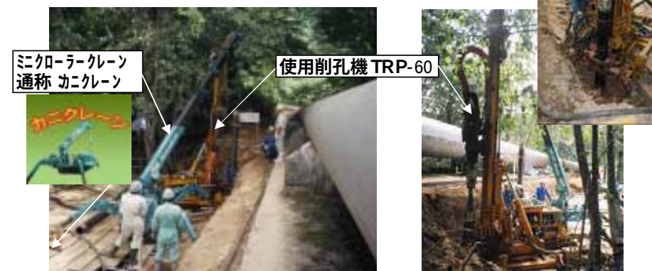
施工状況写真
