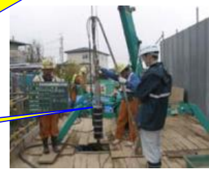
油圧パッカーを使用しての注入作業
