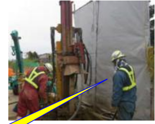
STマイクロパイル
