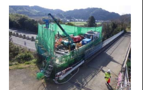
施工状況全景
