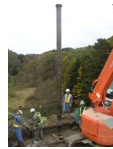
内管挿入状況
