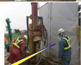
STマイクロパイル
