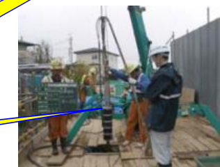
油圧パッカーを使用しての注入作業
