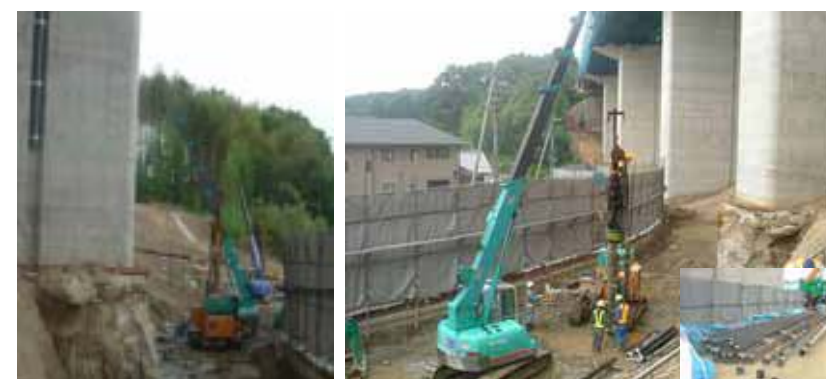
施工状況写真
