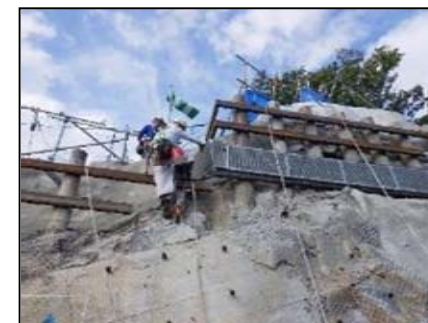
杭頭結合施工状況
