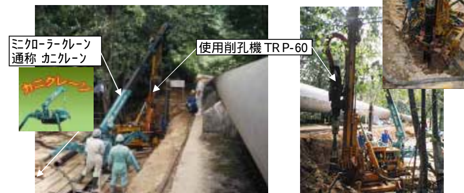
施工状況写真
