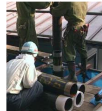
二重鋼管建込み状況
