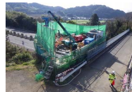
施工状況全景
