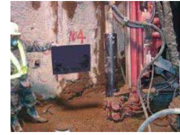
施工状況写真
