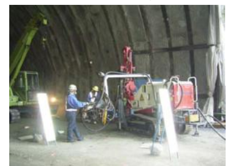
削孔状況(近景)
