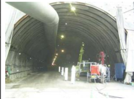
削孔状況(遠景)
