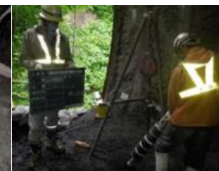
パッカー挿入状況
