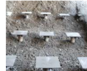
頭部処理状況
