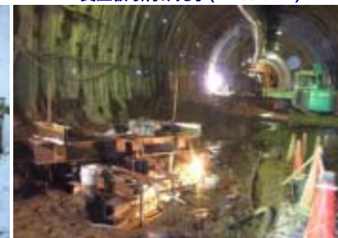
支圧板取付け完了 (口700 t=14)
