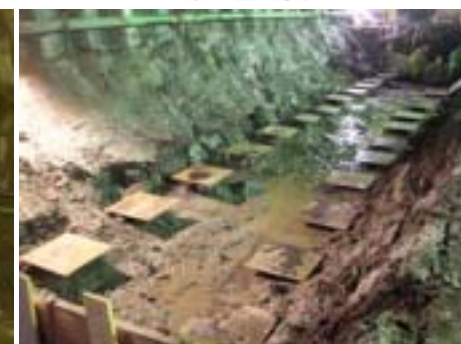
支圧板取付け完了 (口700 t=14)
