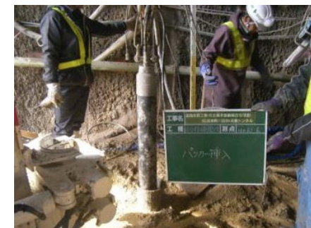
注入状況(パッカーセット)
