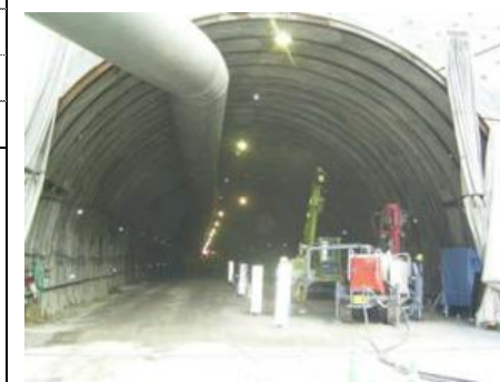
削孔状況(遠景)
