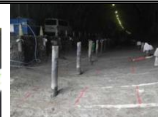
施工完了(さや管付)
