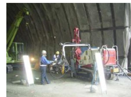
削孔状況(近景)
