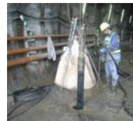
パッカー注入状況
