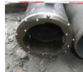
リングビット取付状況
