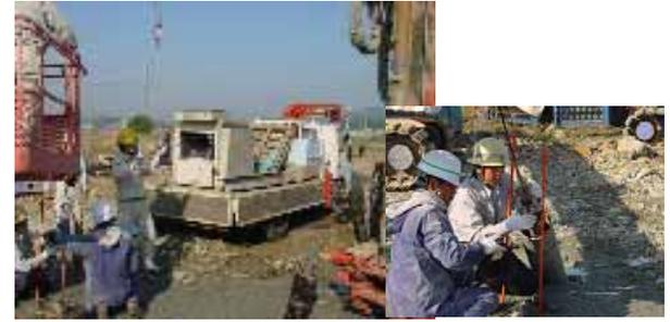
ジャイロ式穴芯測定器による削孔精度測定状況
