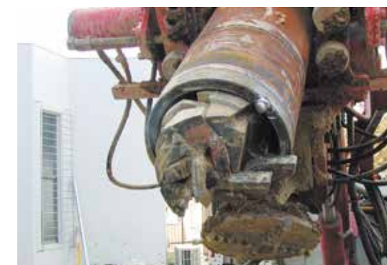
削孔ツール装備状況
