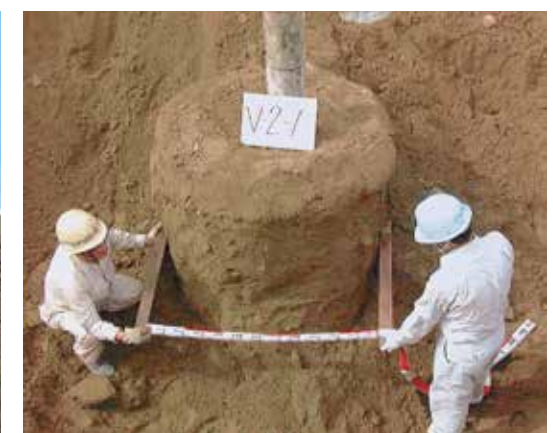
改良体造成状況
