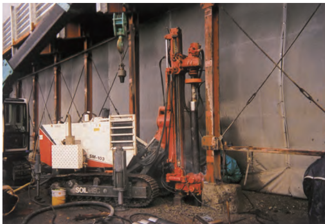
杭径 \phi 165.2mm、L=10.5～16.5m
