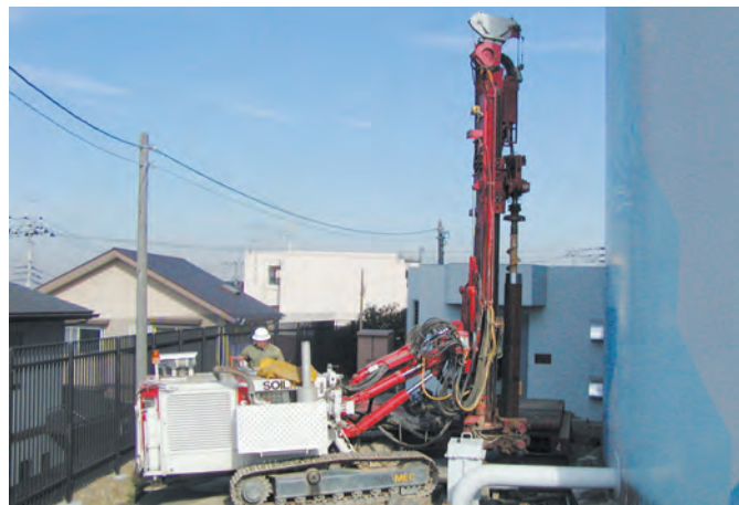
杭径 \phi 267.4mm、L=7m
