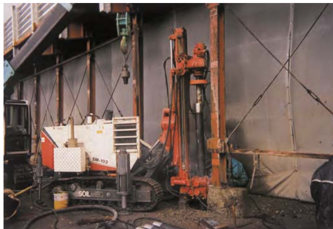
杭径 \phi 165.2mm、L=10.5～16.5m
