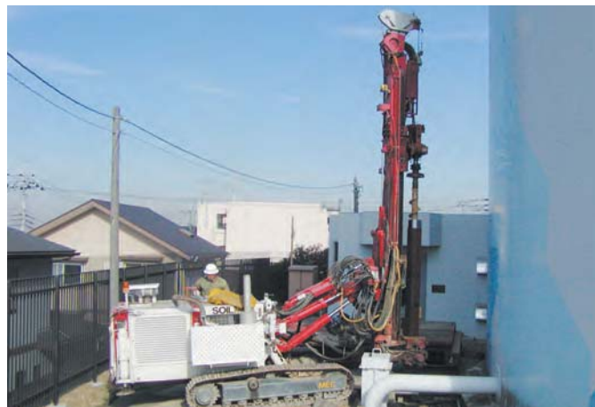
杭径 \phi 267.4mm、L=7m
