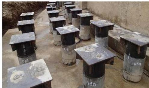
図-解 3.8.8 杭頭管方式による杭頭結合（例）
