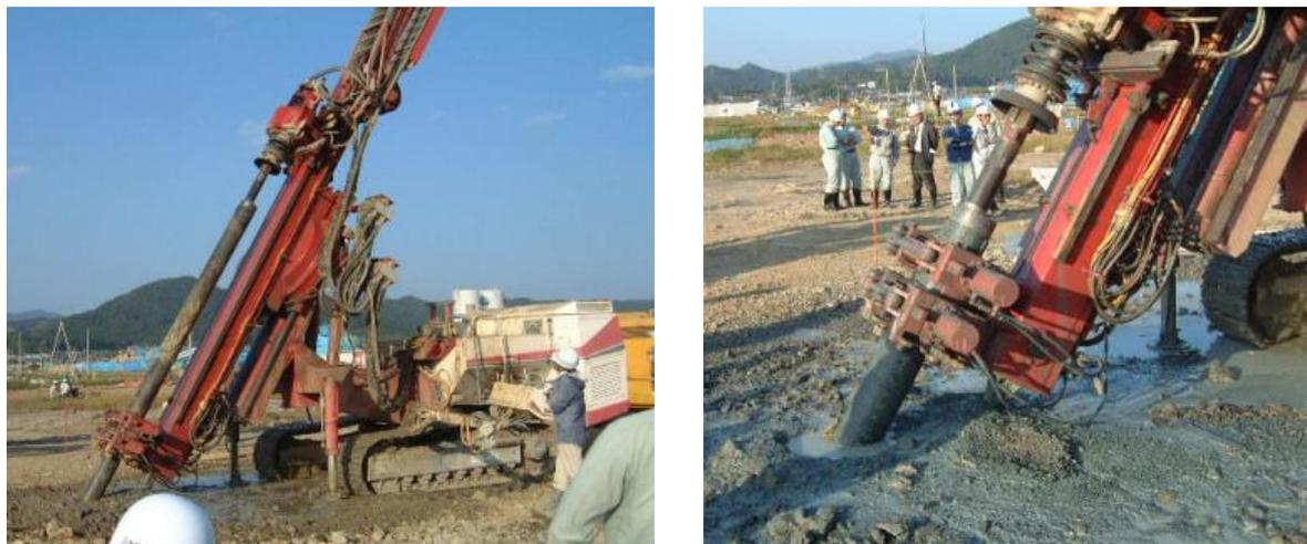
図-解 5.3.8 斜杭 ( $30^\circ$ ) の削孔状況<sup>1)</sup>
