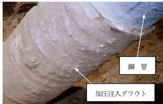
図-解 5.5.8 掘削後のグラウト表面状況
