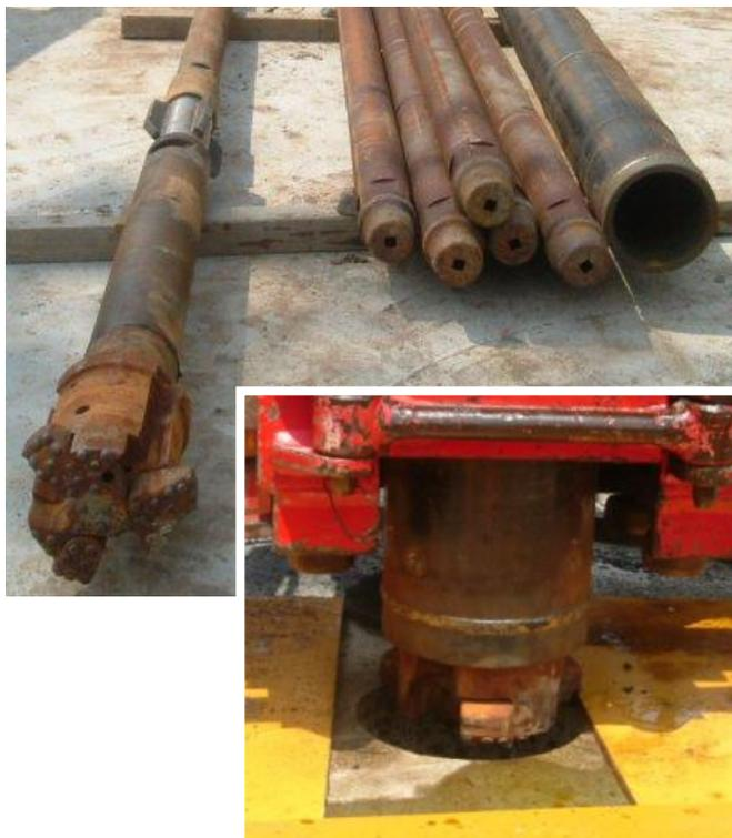
図-解 5.3.4 拡張ビットによる削孔状況
