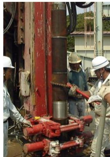
図-解 5.4.2 鋼管接続状況
