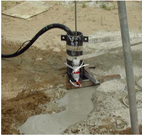
図-解 5.6.7 グラウトの注入・充填状況
