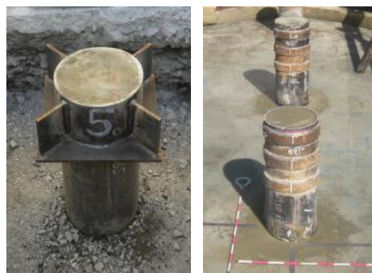
a: 標準型 b: 反転型 c: せん断リン 図-解 3.8.2 杭頭結合の例
