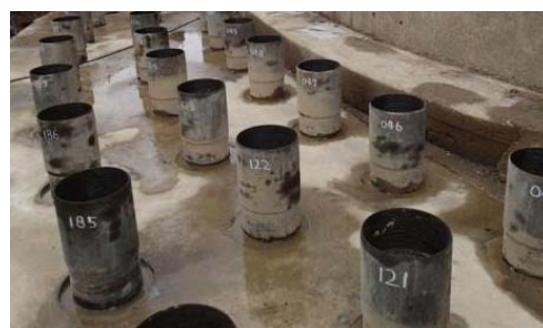
杭頭管設置後
