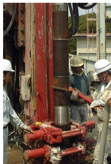
図-解 5.5.2 鋼管接続状況
