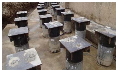
図-解 3.8.8 杭頭管方式による杭頭結合（例）
